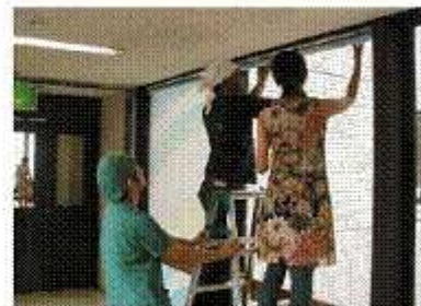
手術室前廊下に、自然をモチーフとしたプリントを施したロールスクリーンを設置しているところ。
